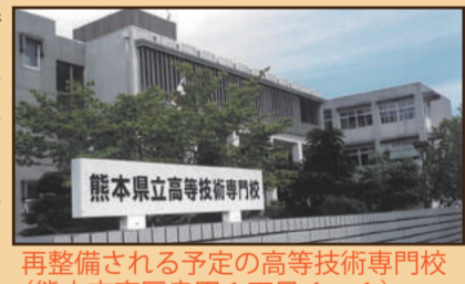
再整備される予定の高等技術専門学校(熊本市南区幸田1丁目4-1)
