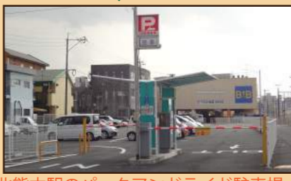
北熊本駅のパークアンドライド駐車場
